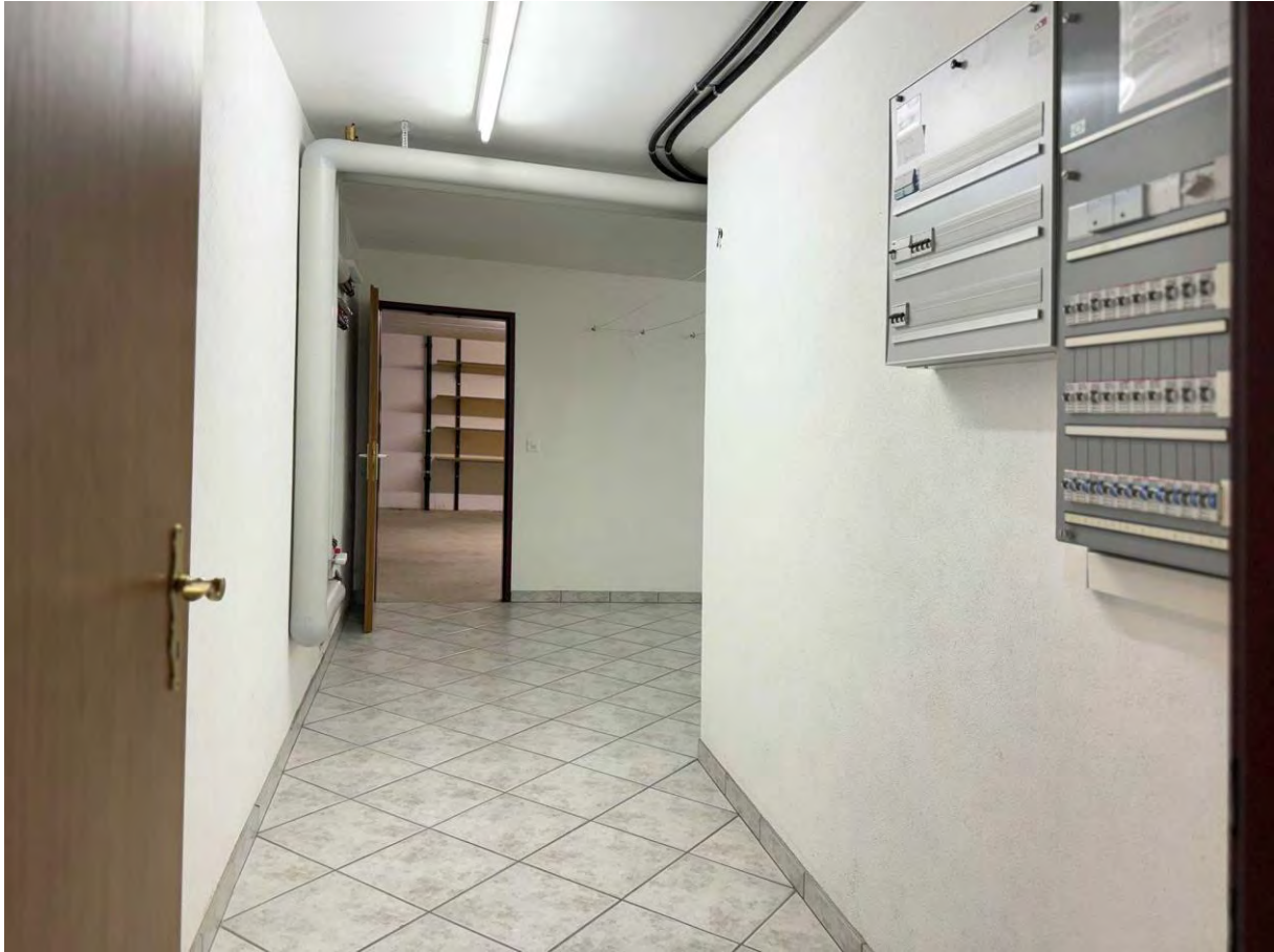
Durchgang Technik ins Lager / Werkstatt
