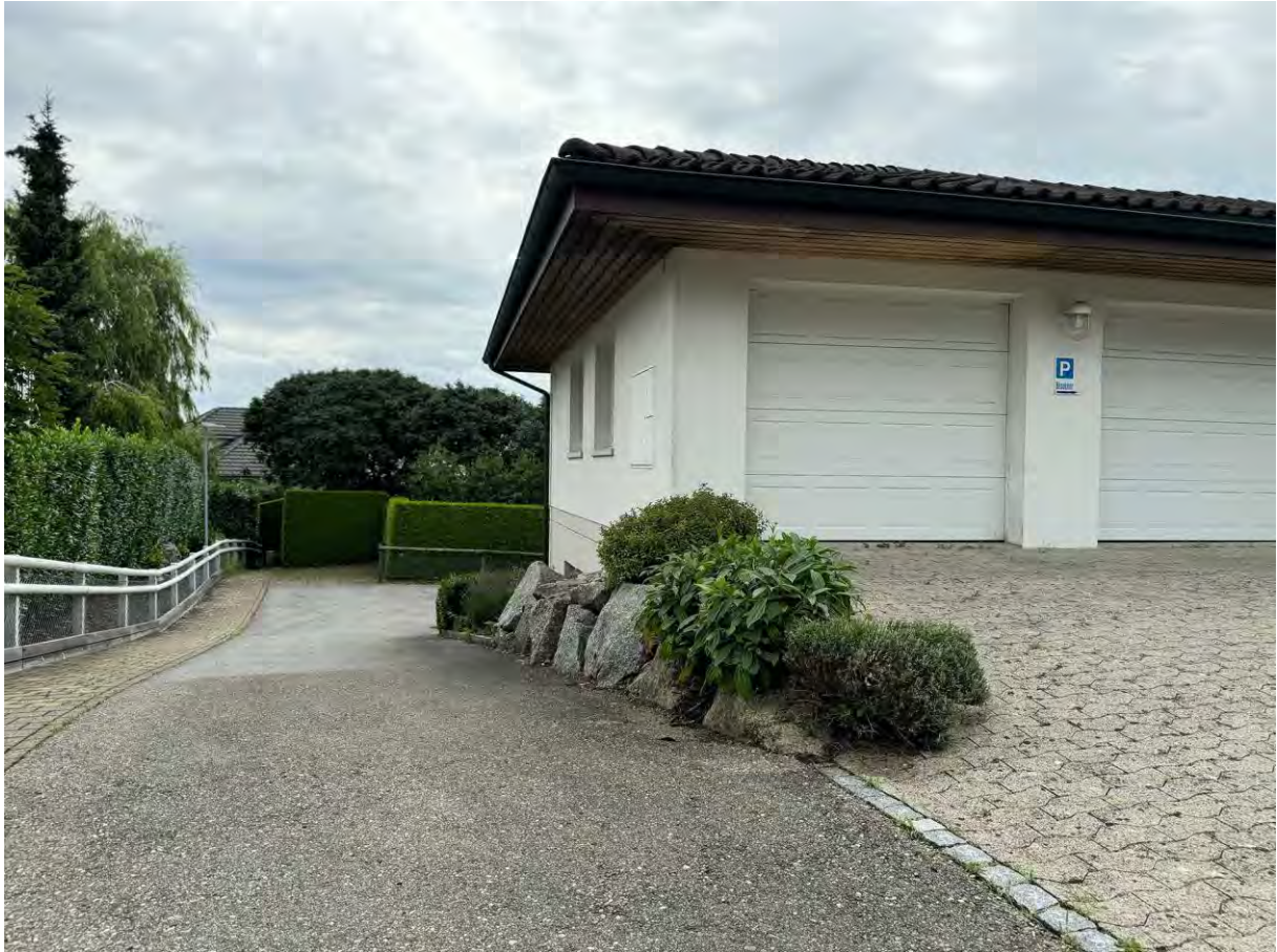
Zufahrt zu Untergeschoss
